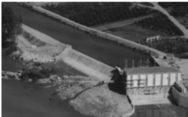
Figura nº 2. Minicentral hidroeléctrica fluyente.
