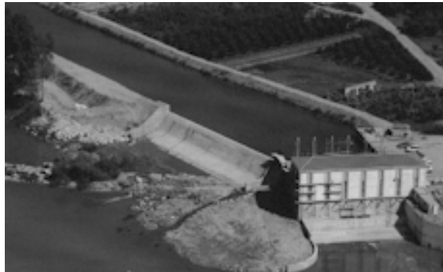
Figura nº 18. Minicentral hidroeléctrica fluyente.
